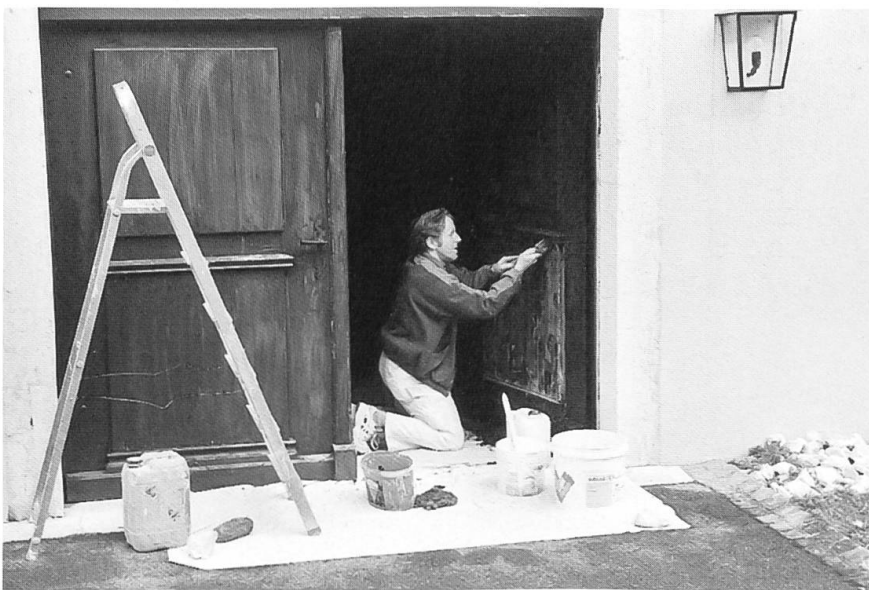
Im März und April wurden verschiedene Unterhaltsarbeiten ausgeführt: In einigen Räumen wurde der Spannteppich durch einen Parkettboden ersetzt, in den Sprechzimmern wurde der Boden neu versiegelt (oben), und der Maler gab unter anderem den Aussentüren einen neuen Anstrich (links).
