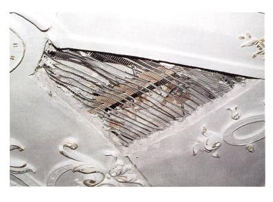
Schadhafte Stellen und Risse in den Gewölben mussten mit eingebautem Wendel und Streckmetall ausgebessert werden.
