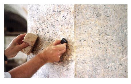
Der Stuckmarmor der Säulen musste in einem aufwändigen Verfahren mehrmals poliert werden.
