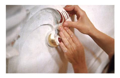
Beim Vergolden der Stuckaturen: Auf die mit roter Spezialfarbe behandelten Teile wird eine hauchdünne Goldschicht aufgetragen.
