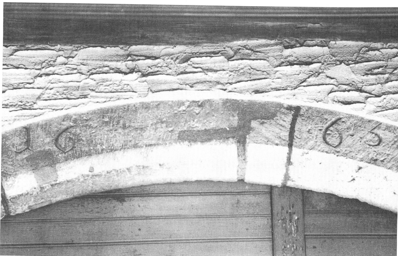
Torbogen mit der Jahreszahl 1663 aus der älteren Bauphase des Hofes.
