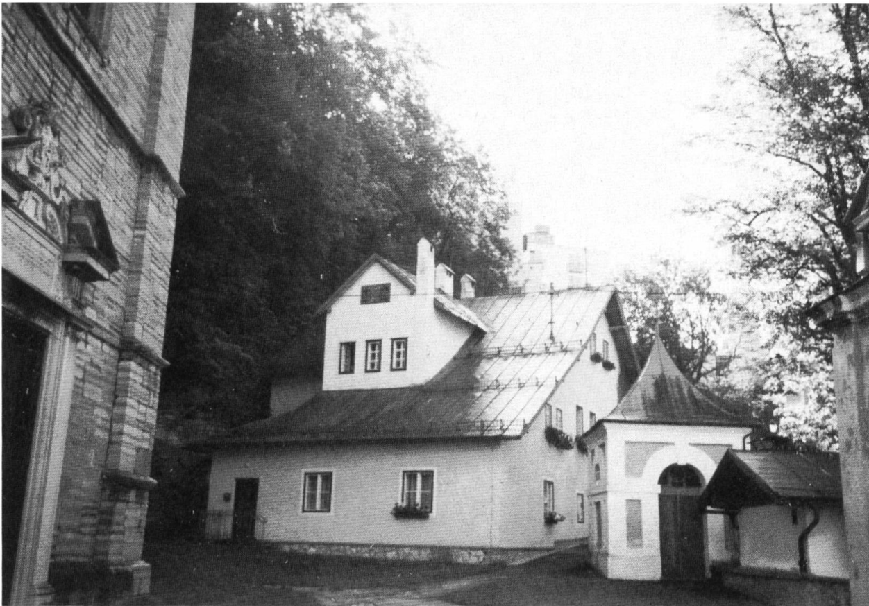
Das dem «unteren Haus» gegenüberliegende alte Schulhaus auf dem Dürrnberg.
