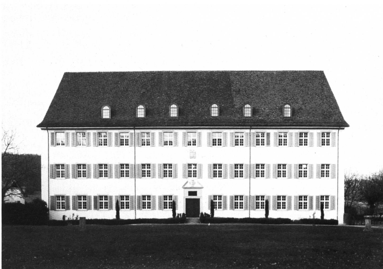
Südfassade mit den neuen Dachgauben.
