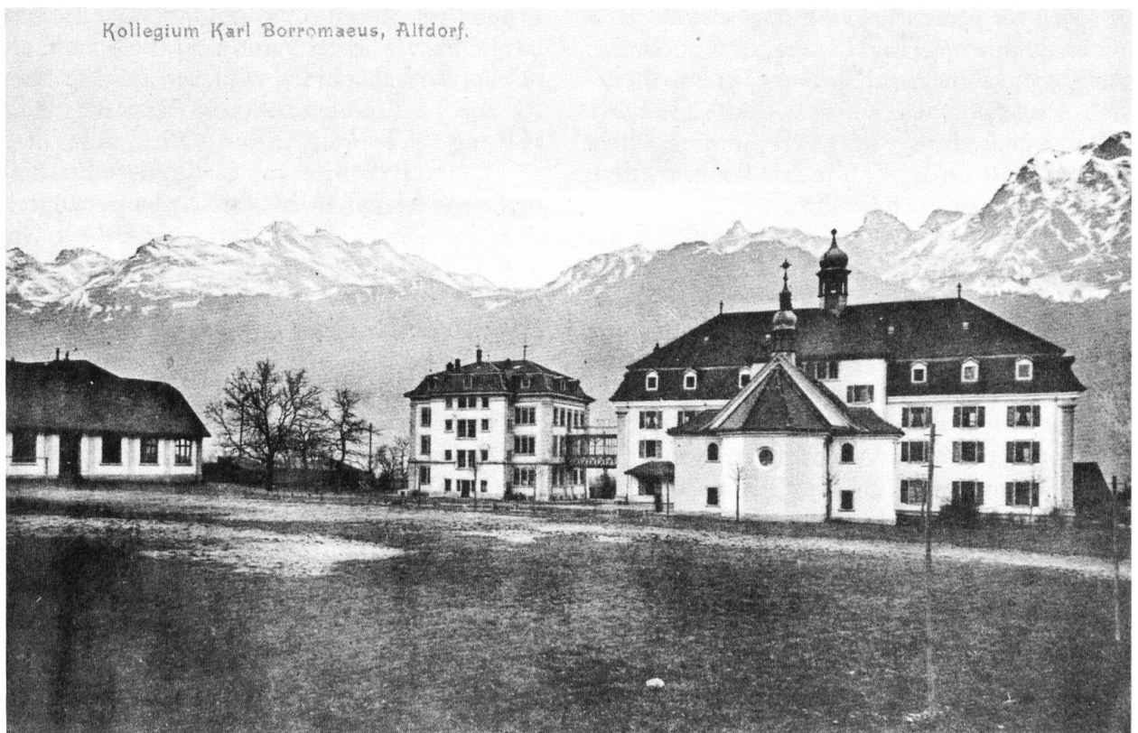
Westansicht des Kollegiums mit Kapelle, daneben das Schulhaus, ganz links die Turnhalle.
