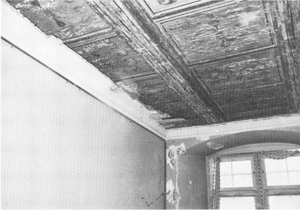
Kapitelsaal. Auch hier liegt unter der Gipsdecke eine bemalte Täferdecke. Die aus der Pflanzenwelt entlehnten Motive waren mit Krapplack gemalt.
