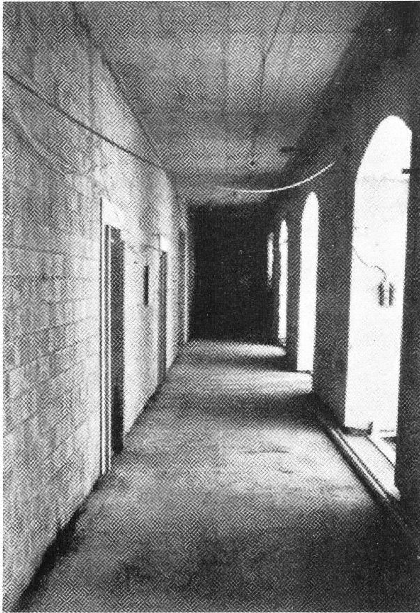
Bibliothekstrakt, Robbau , der künftige südliche Kreuzgangarm.
