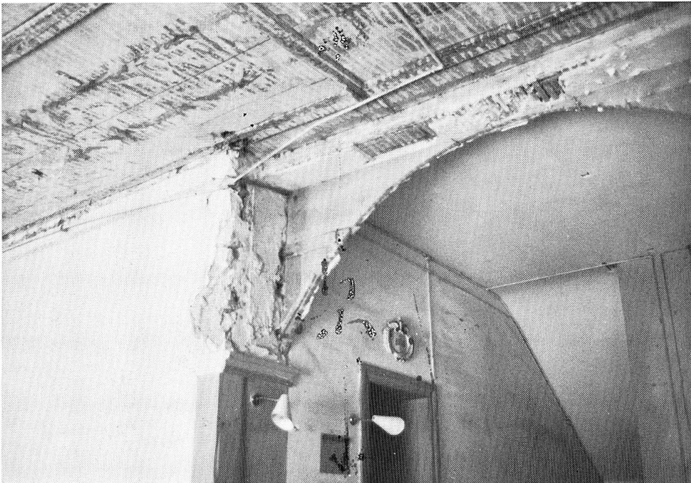
Konventstock, Erdgeschoss. So zeigte sich die mit Ranken bemalte Täferdecke, nachdem die Gipsdecke entfernt war.
