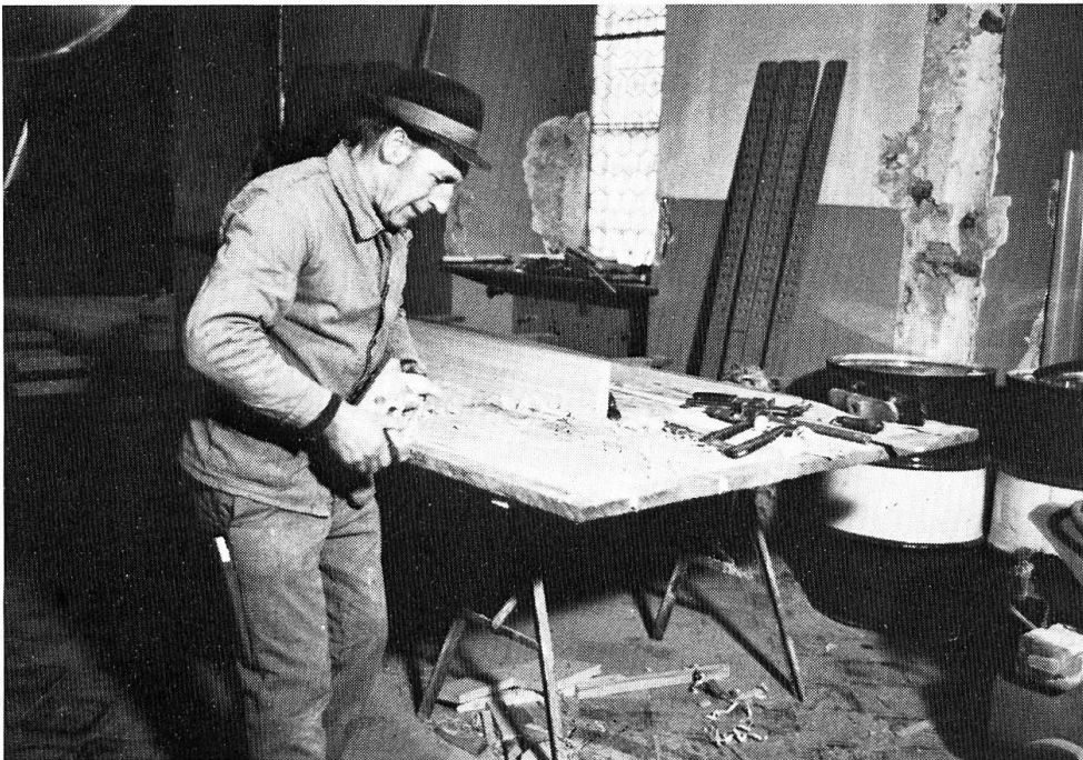
Konventstock, Täferdecke. Herr Richard Malzach von Erschwil, Schreiner, setzt die zerrissenen Tafeln zusammen und verleimt sie neu.
