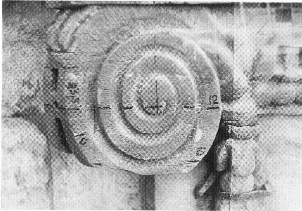
Altes ionisches Kapitell. Die eingezeichneten Masse werden auf das neu zu schaffende Werk- stück übertragen.
