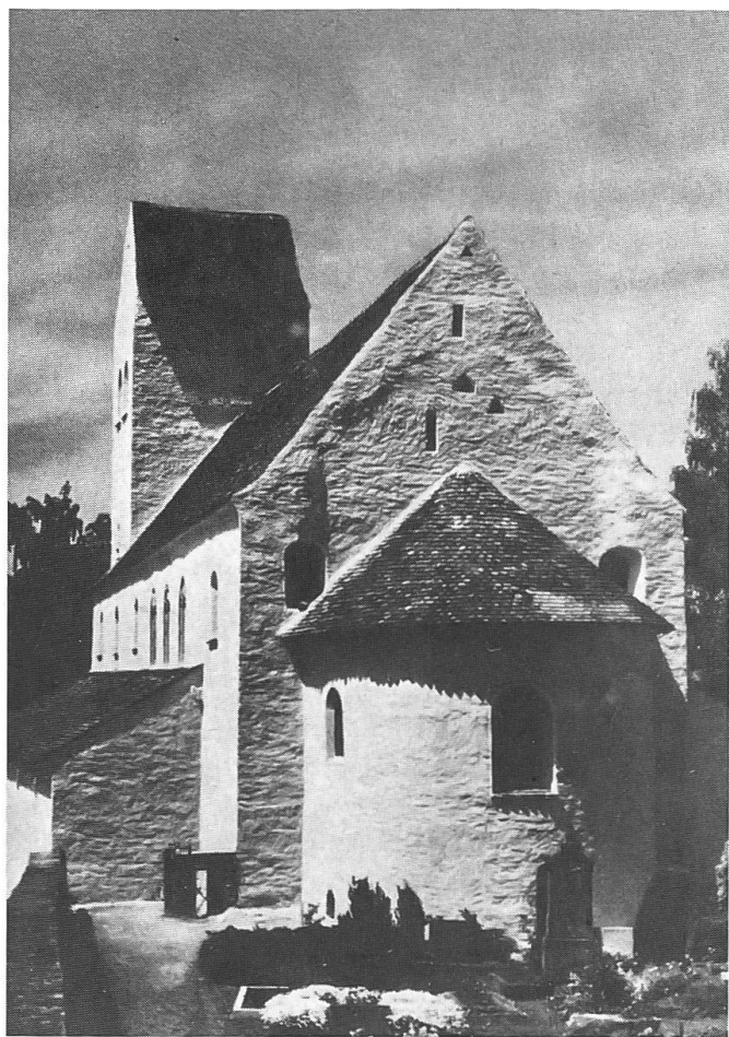
Sulzburg: St. Cyriak von Osten.
