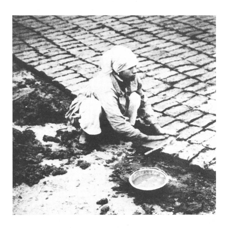
Herstellung der sonnengetrockneten Ziegel, wobei kleingeschnittenes Stroh dem Nilschlamm als Bindemittel beigemischt wird.
