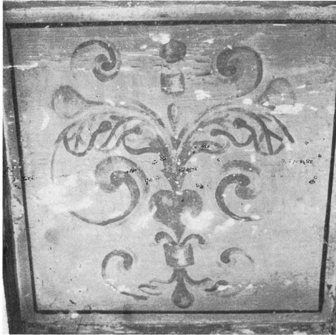
Kapitelsaal. Bemalte Holztafel mit Gipspritzern und Fehlstellen in der Malerei.
