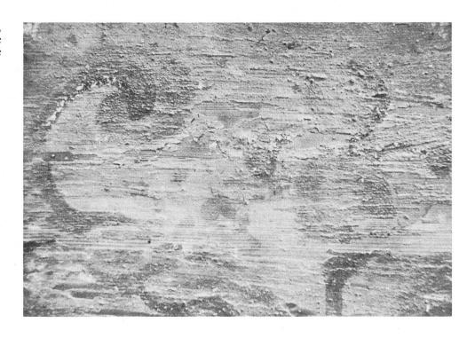
Kapitelsaal. Freilegung. Pickelhiebe mit Gipsresten. Der ursprüngliche Putz wurde aufgehackt, damit die nachfolgende, neue Schicht auf dem alten Putz besser hafte. Diese Gipsreste mussten sorgfältig entfernt und die «Löcher» mit Kalkmörtel wieder ausgestrichen werden.
