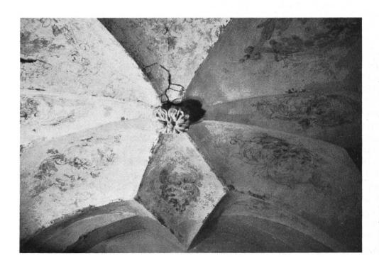
Konventstock, Erdgeschoss. Ein sehr schwieriges und nervenkostendes Unterfangen war das Hervorholen und Reinigen des Sterngewölbes an der Nordseite des Ganges. Nach Entfernung des Drecks und nach dem Fixieren der noch vorhandenen Malerei wurden die Tafeln lasierend ausgefasst.
