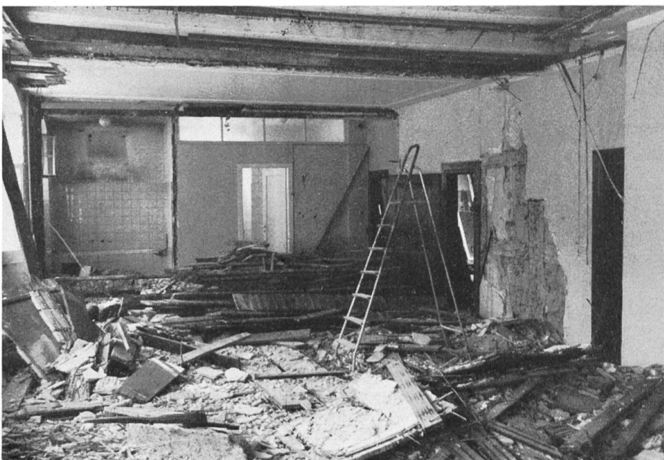
Konventstock, Süd-Ost-Seite. Die mit Brettern eingefügten Zwischenwände wurden herausgenommen und durch eine neue Riegelkonstruktion ersetzt. Hier war ursprünglich die alte Bibliothek.
