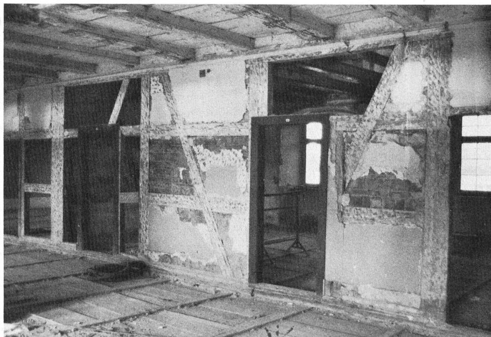
Konventstock, gestörte Riegelkonstruktion.
