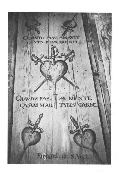
Konventstock. Fragmente der alten Decke aus der Siebenschmerzenkapelle. Die Tafeln dienten als Träger der Gipsdecke in einem Zimmer des zweiten Stockes.
