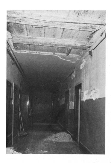
Konventstock, Gang, 1. Obergeschoss. Unter der Gipsdecke — wie überall — die alte, mit Kalk getünchte Balkendecke.
