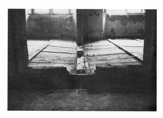
Konventstock, ein abgesackter Zwischenriegel. Die Bodenunebenheiten betrugen bis zu 25 cm.
