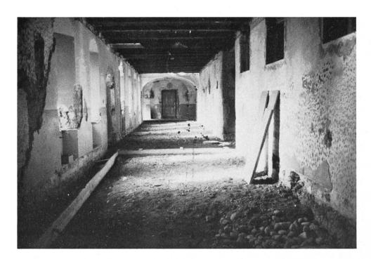
Konventstock, Erdgeschoss. Der Gang wurde trockengelegt und ist nun bereit, die Unterkonstruktion für den Bodenbelag aufzunehmen.
