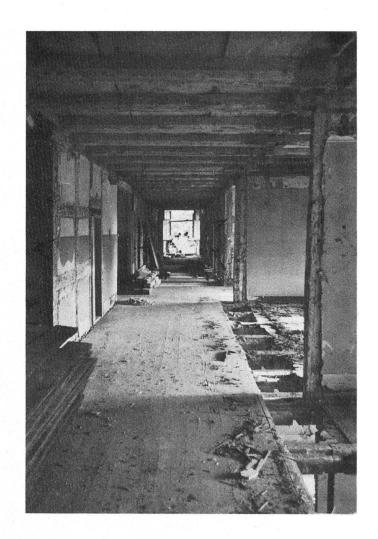
Konventstock, Nord-West-Seite. Die 1727 aufgeführte Mauer wurde wieder entfernt und durch eine neue Riegelkonstruktion ersetzt. In ihrem Bereich war der Gang etwa 30 cm schmäler, auch war ein Teil des Balkenprofils und der Kerbschnitt in sie eingemauert.
