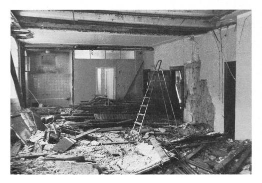
Konventstock, Süd-Ost-Seite. Die mit Brettern eingefügten Zwischenwände wurden herausgenommen und durch eine neue Riegelkonstruktion ersetzt. Hier war ursprünglich die alte Bibliothek. Konventstock, gestörte Riegelkonstruktion.
