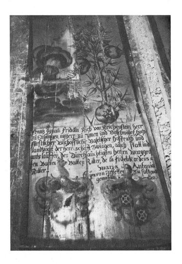
Konventstock. Fragmente der alten Decke aus der Siebenschmerzenkapelle. Die Tafeln dienten als Träger der Gipsdecke in einem Zimmer des zweiten Stockes.
