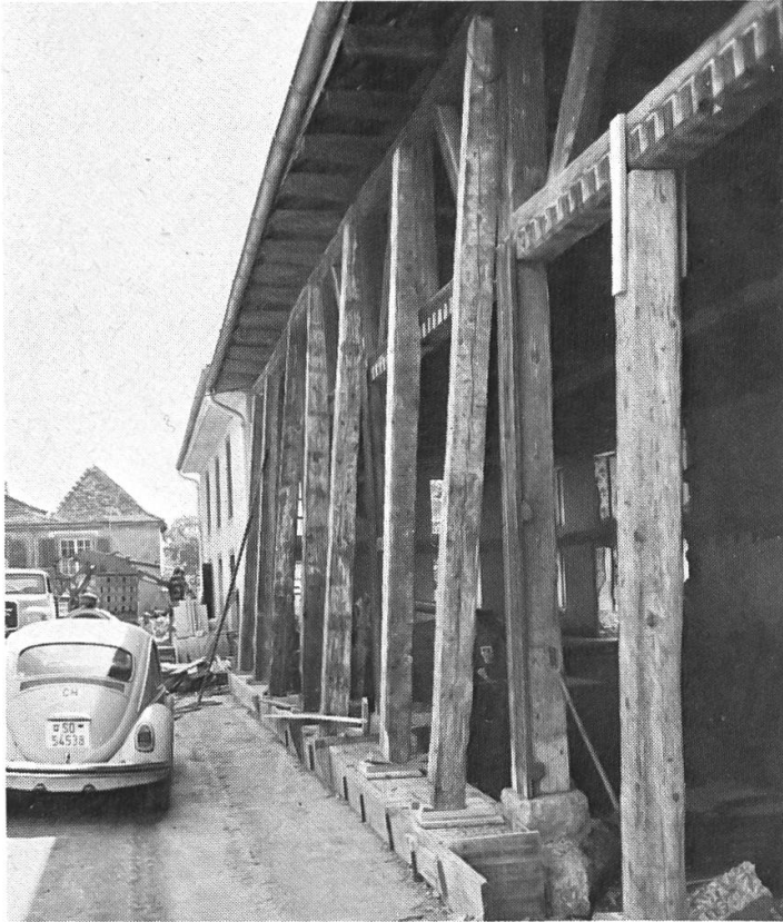
Die Lasten des Daches wurden zum Ausbaggern des Kellers auf einem Betonriegel abgefangen.
