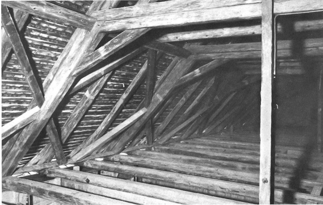
Dachstuhl. Die etwa 150jährige Konstruktion ist noch äusserst solide und bis auf einige Sparren, die ersetzt werden mussten, kerngesund.
