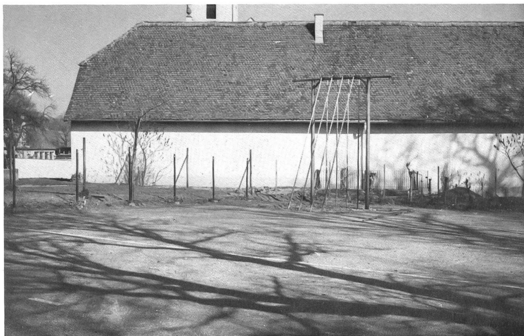
Altes Ökonomiegebäude, Südseite (vom ehemaligen Turnplatz der Bezirksschule aus gesehen)
