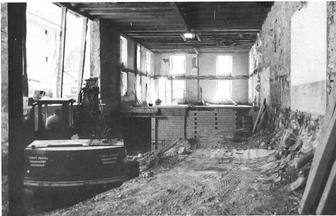
Das Haus wird ausgehöhlt. Im Untergeschoss werden ein Personen- und ein Kulturgüterschutzraum eingebaut.
