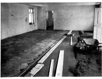
Die Halle nimmt Gestalt an. Bereits wird der Boden verlegt. Die Platten — Rosenspitz kombiniert — brannte die BIK Lausen. Das Muster entspricht den Massen des alten Bodens im ehemaligen Kreuzgang.
