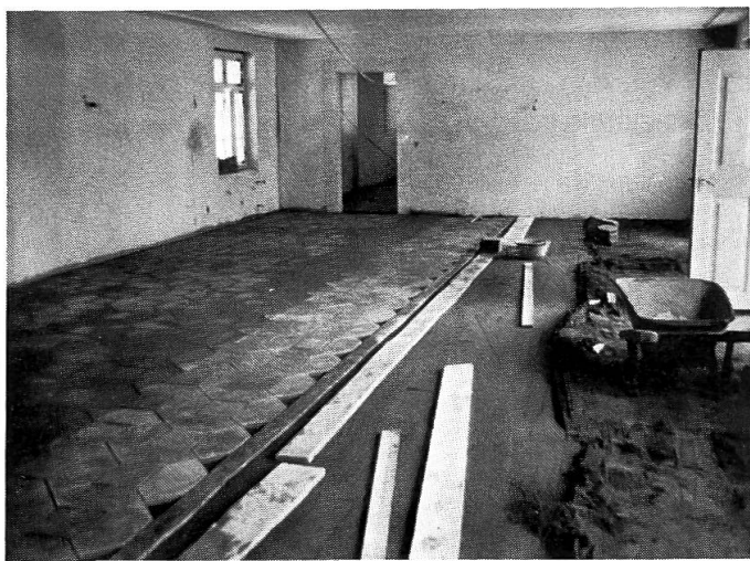
Die Halle nimmt Gestalt an. Bereits wird der Boden verlegt. Die Platten — Rosenspitze kombiniert — brannte die BIK Lausen. Das Muster entspricht den Massen des alten Bodens im ehemaligen Kreuzgang.
