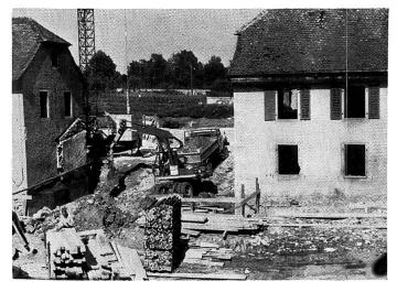
Nach Vollendung der Fundamentunterfangung der beiden Giebelmauern wird mit dem Aushub für den Tankraum begonnen.
