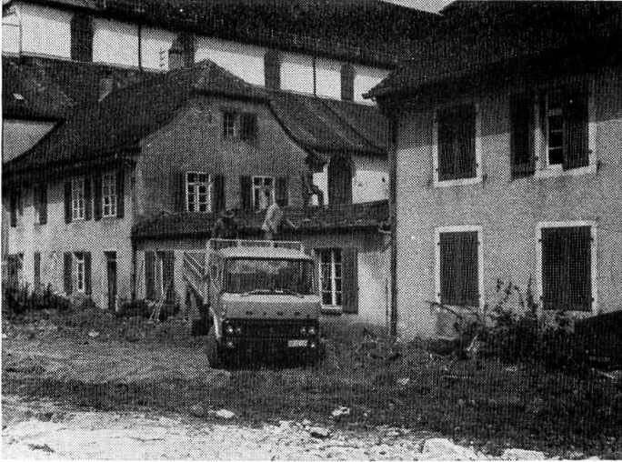
Als erstes muss das ehemalige «Treibhaus» Haare lassen.
