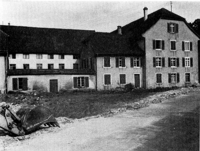
Ruhe vor dem Sturm. — Noch steht der baufällige Zwischenbau. Aber selbst so hat die Fassade schon etwas für sich.
