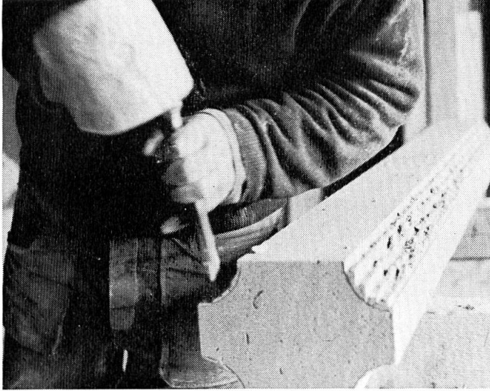
Die rohe Form eines Masswerkes — Fischblasenmotiv — wird bearbeitet.
