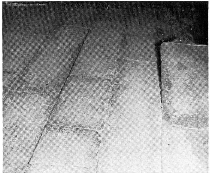
Alter, englisch verlegter Plattenboden in der Basilika. Bruchstückweise kam dieser Boden unter dem Plättli-boden zum Vorschein.
