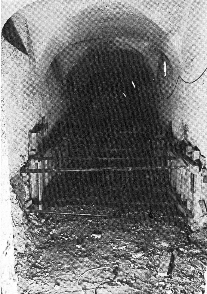
Der alte Gnadenkapellengang wurde etwas tiefer gelegt, um einen nahtlosen Uebergang zum neuen Kapellengang zu bekommen.
