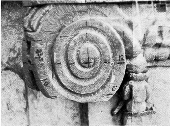
10 Altes ionisches Kapitell. Die eingezeichneten Masse werden auf das neu zu schaffende Werkstück übertragen.
