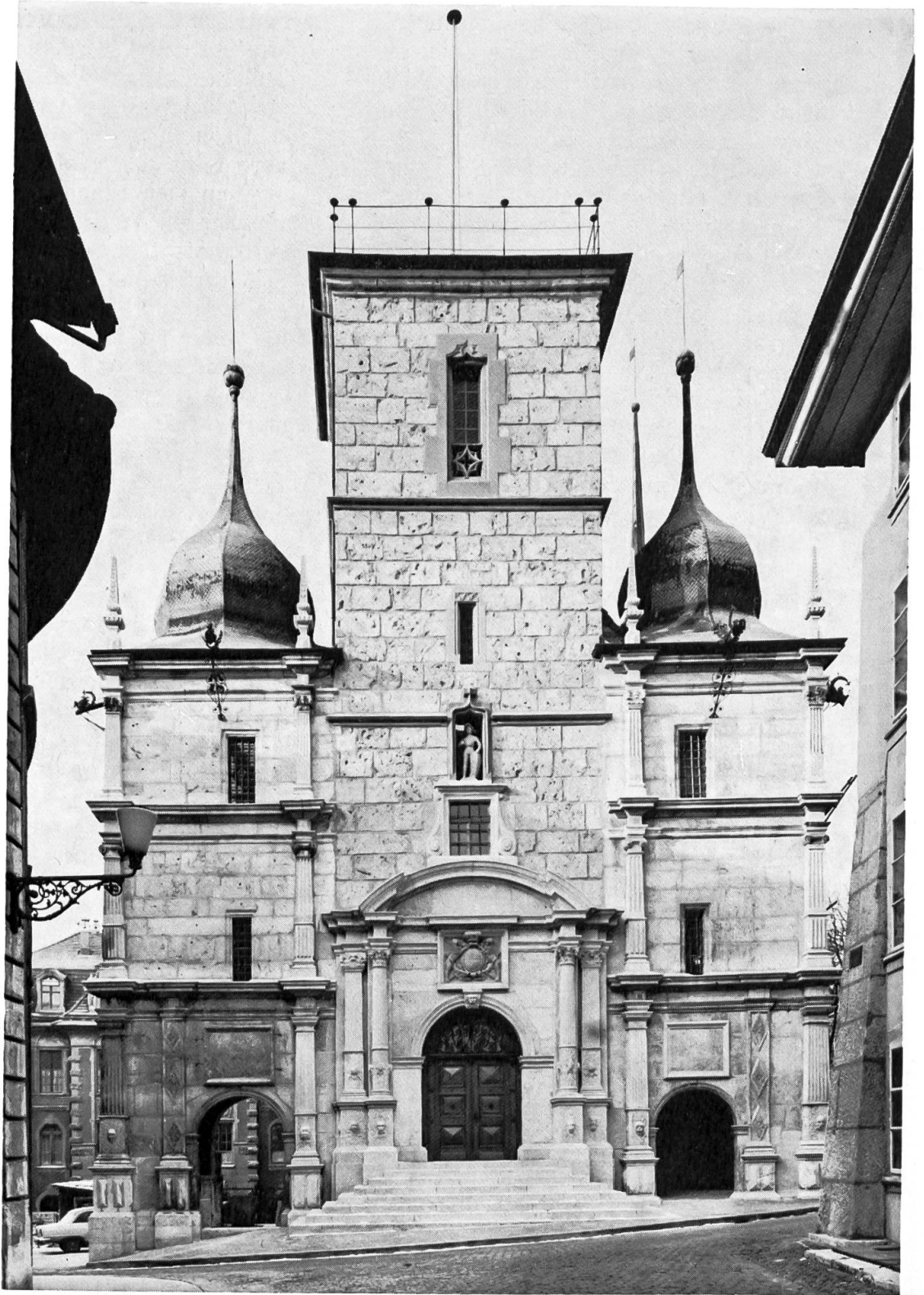
Rathaus, Ostfassade, Mittelturm (ehemals mit Spitzhelm) 1476; Seitenpavillons und Portal zwischen 1623 und 1711.
