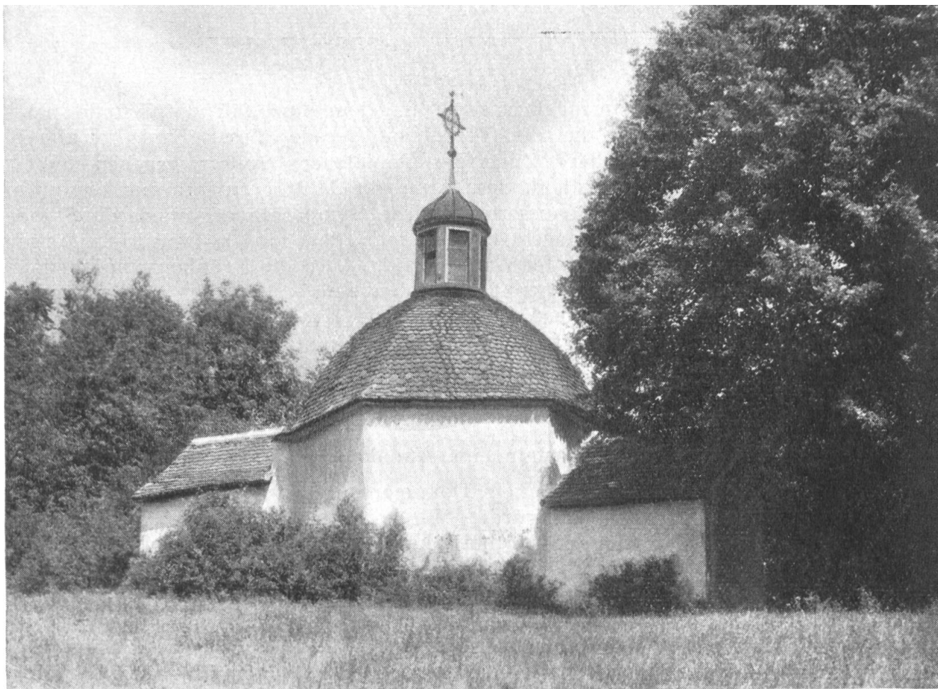
Die St. Annakapelle vor der Restauration.
