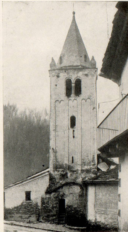
Lisenen der Ostseite zu Bourg-St-Pierre (Wallis).
