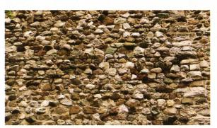
Nordwand des Steinbaus aus dem 12. Jahrhundert. Zur Belichtung des Kellers dienten drei später zugemauerte Lichtscharten. In den viereckigen Löchern waren die Holzbalken der Decke verankert. Darüber, in der Bildmitte, befinden sich die beiden Säulen, welche den Kaminhut trugen. (Kantonsarchäologie Zürich)
