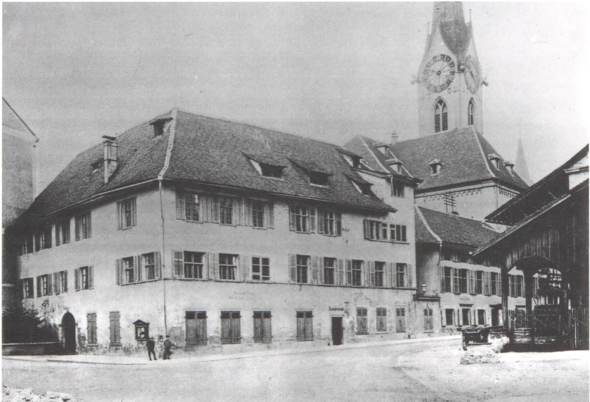
Abb. 1: Blick vom Limmatufer auf den 1506–1508 erbauten Äbtissinnenhof (nach der Reformation Fraumünsteramtshaus). Das Eckzimmer im ersten Obergeschoss links war die «Amtsstube» Katharinas von Zimmern, das Eckzimmer im zweiten Obergeschoss rechts mit dem niedrigeren Reihenfenster ihre Privatstube. (Foto: Robert Breitingen, 7. Mai 1891. Baugeschichtliches Archiv der Stadt Zürich)
