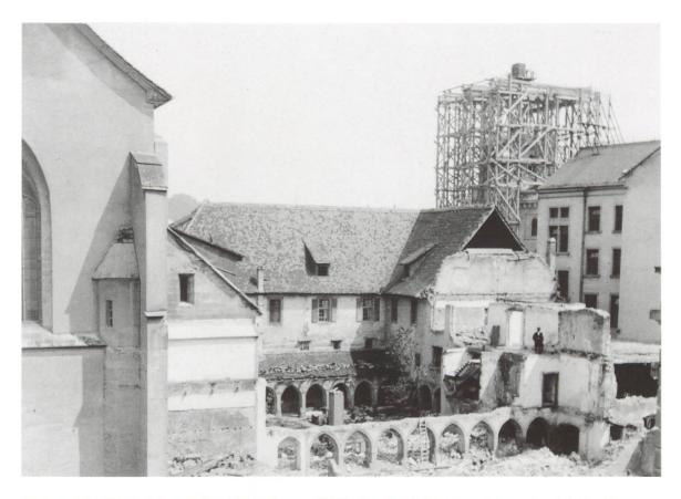
Abb. 3: Die Abtei während des Abbruchs um 1898. Der Blick Richtung Limmat zeigt den Kreuzgang und die daran anschliessenden Konventgebäude (Bildmitte). Im Hintergrund wird bereits der Eckturm der Fraumünsterpost gebaut (im Baugerüst). (Baugeschichtliches Archiv der Stadt Zürich)
