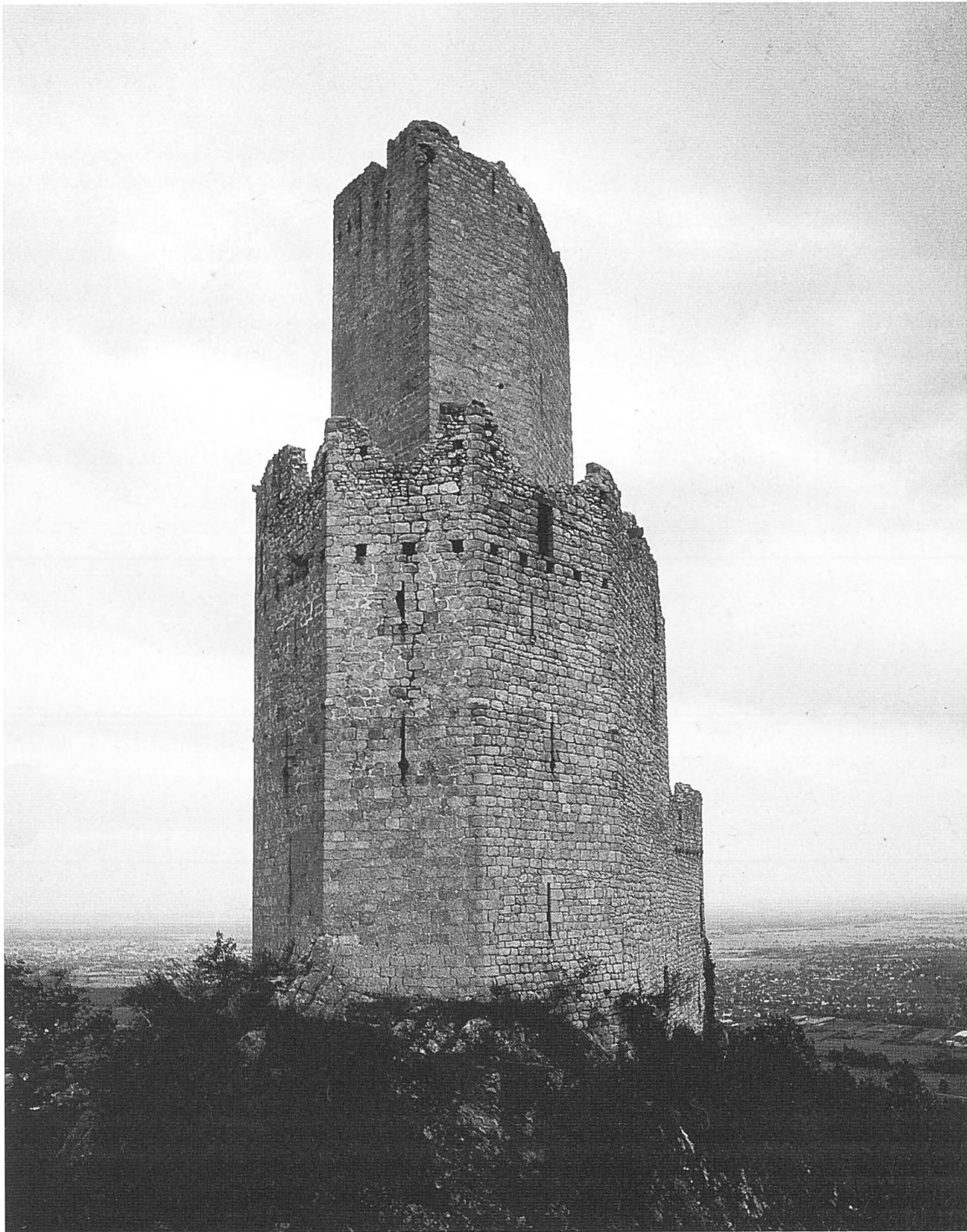
8. Der fünfeckige Hauptturm und die hohe, mit zahlreichen Schiesscharten ausgestattete Mantelmauer verleihen Ortenberg einen besonders wehrhaften Charakter. (Foto Werner Wild)
