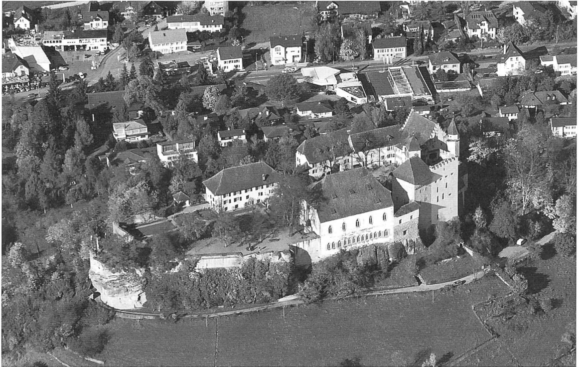
12. Das noch zur Hälfte erhaltene Ritterhaus und die Bauten der Grafenburg dominieren die Südansicht der Lenzburg. (Foto Simon Vogt, Kantonsarchäologie Zürich)
