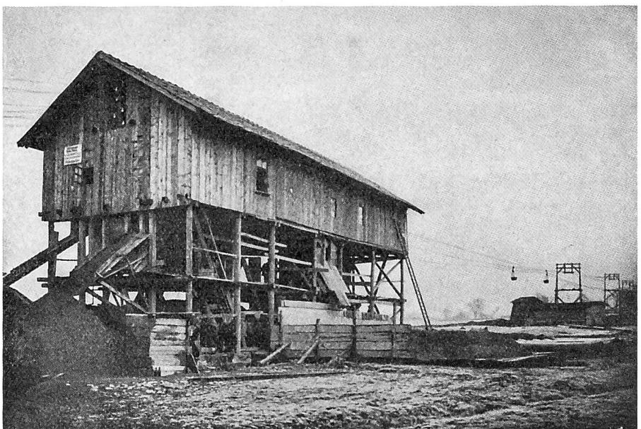
Frisches Trinkwasser aus dem Zürichsee. Das Seewasserwerk Moos war schon bei der Eröffnung 1914 für die Aufbereitung von täglich 105'000 Kubikmeter Wasser ausgelegt. Die Pumpstation am Seeufer befördert das in grosser Tiefe gefasste Wasser in die über fünfzig Meter höher gelegene Filteranlage. Die für deren Bau benötigten 38'000 Kubikmeter Kies und Sand wurden mit einer zu diesem Zweck erstellten, elektrisch betriebenen Luftseilbahn vom Seeufer auf den Bauplatz transportiert. (Fotos BAZ)
