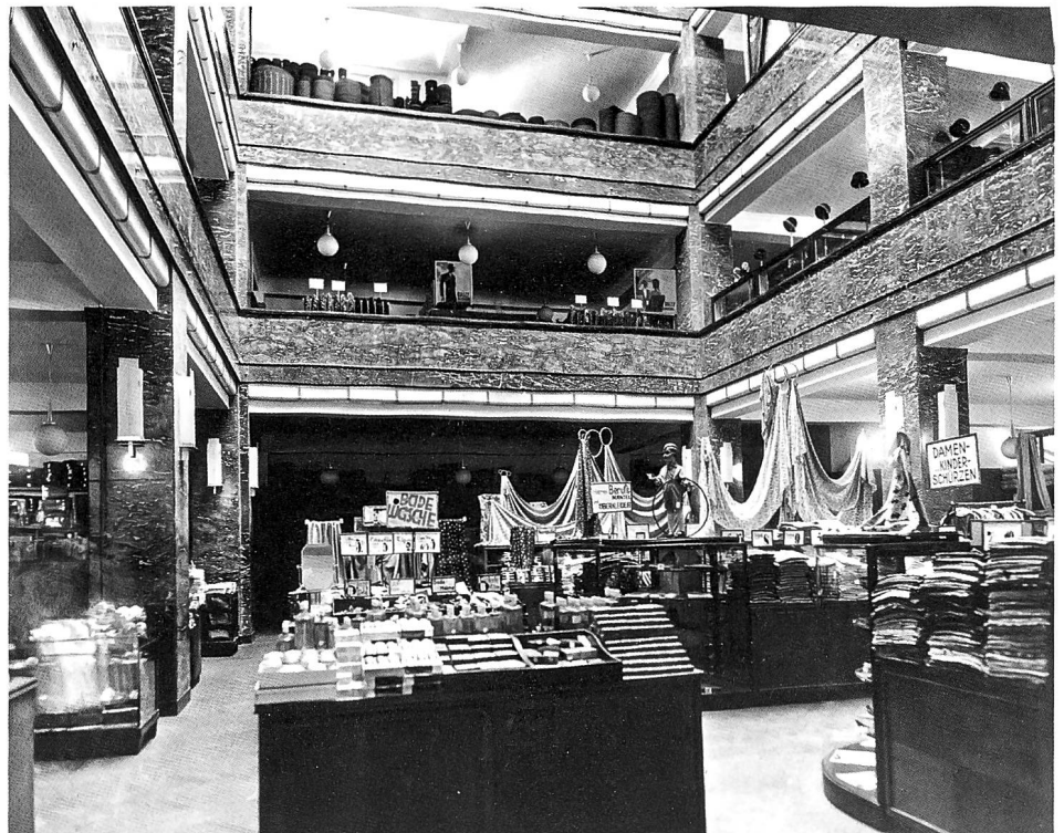
Aktuelle Ansicht des Manor an der Ecke Urania- / Usterstrasse von 2006. Die Aussenfassade der in Glas aufgelösten Wände von 1928 wurde bis auf einige Details beibehalten. Der Lichthof im Inneren des Warenhauses Brann mit Brüstungen und Pfeilern aus südfranzösischem Marmor, um 1930. (Fotos BAZ)
