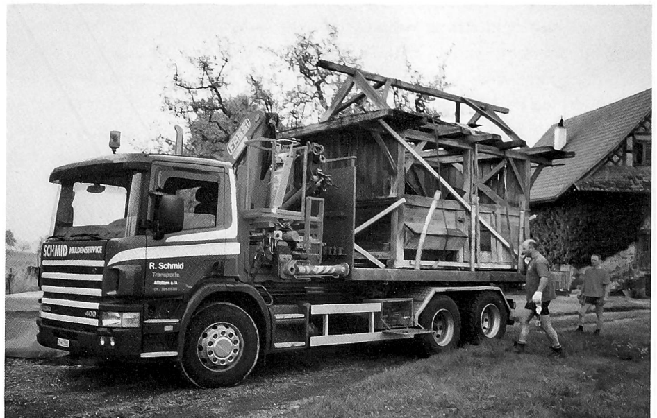
Fahrhabe auf Reisen: Der reastaurierte Schweinehütte am neuen Standort 2001 und seine Versetzung im Jahr 2000. (Fotos Kantonale Denkmalpflege Zürich)
