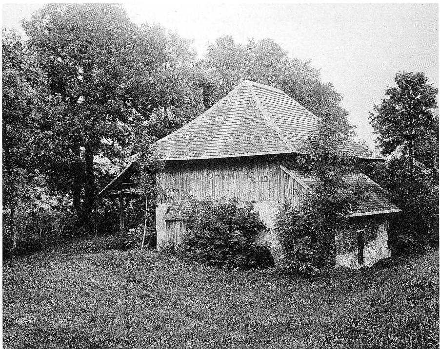
Unterhalb der «Eichmühle» von Hettlingen liegt in einer kleinen Senke die um 1822 erbaute Hanfreibe, ein im Erdgeschoss gemauertes, oben mit Riegelwerk versehenes Gebäude unter einem Walmdach. Das Innere birgt die praktisch vollständige technische Einrichtung mit dem Reibewerk; der Mahlstein wird von einem hölzernen Zahnradwerk angetrieben. (Fotos Kantonale Denkmalpflege Zürich)
