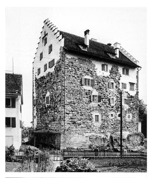
Ost- und Nordfassade des Schlosses Greifensee, wo die Zerstörungen von 1444 beziehungsweise der Wiederaufbau von 1520 am Mauerwerk deutlich abzulesen sind. Aufnahme von 1956.
