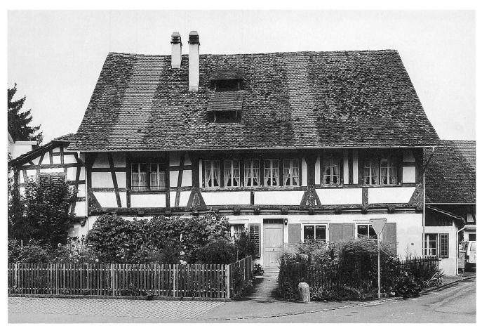
Strassenseitige Fassade. Aufnahme 1994. Die Ständer im ersten Obergeschoss mit den Fussund Kopfhölzern markieren die ursprüngliche Innenunterteilung in Küche (links), Stube (Mitte, mit fünfteiligem Reihenfenster) und Kammer (rechts). Links an das Gebäude wurde 1757 eine «Anhänke» angefügt, die im Obergeschoss das Studierzimmer des Pfarrers enthielt.
