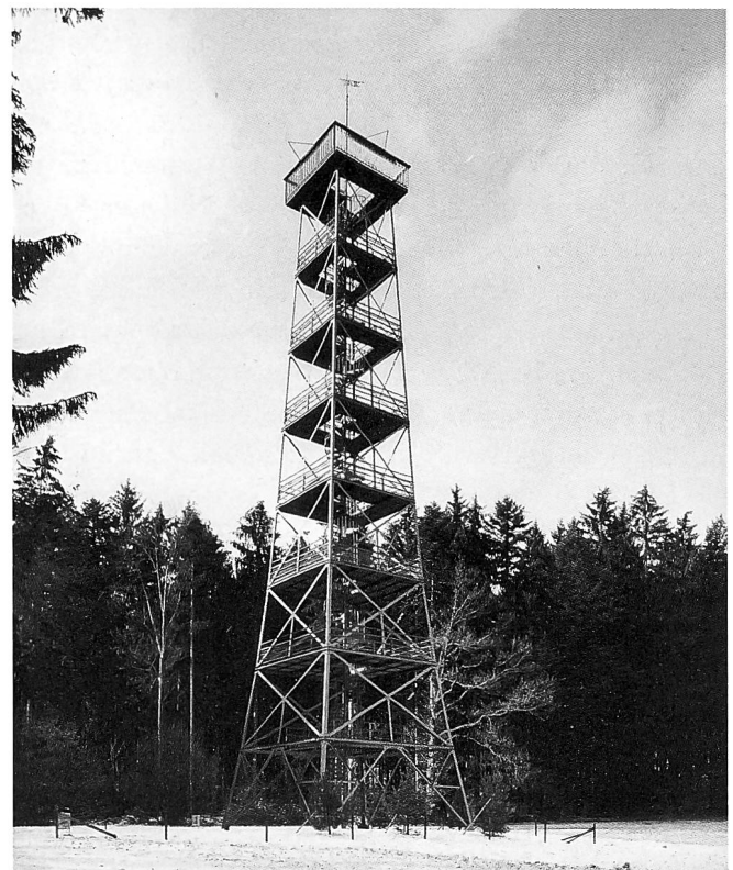
Ansichtskarte vom Bachtel mit dem Turm und dem 1893 nach einem Brand wieder aufgebauten Gasthaus, circa 1905, und der ehemalige Bachtelturm an seinem neuen Standort auf dem Pfannenstiel. (Fotos Kantonale Denkmalpflege Zürich)
