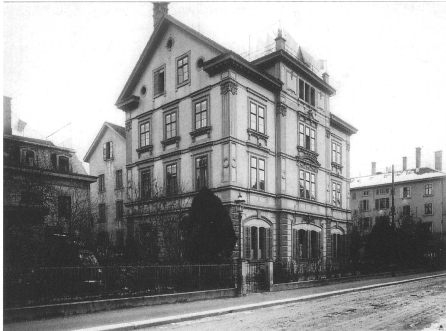
Haus Kasinostrasse 3 in Hottingen. Hier wurden von 1879 bis 1888 der «Sozialdemokrat» sowie Schriften und Flugblätter der deutschen Sozialdemokratie gedruckt und anschliessend ins Deutsche Reich geschmuggelt. (Foto Baugeschichtliches Archiv der Stadt Zürich)
