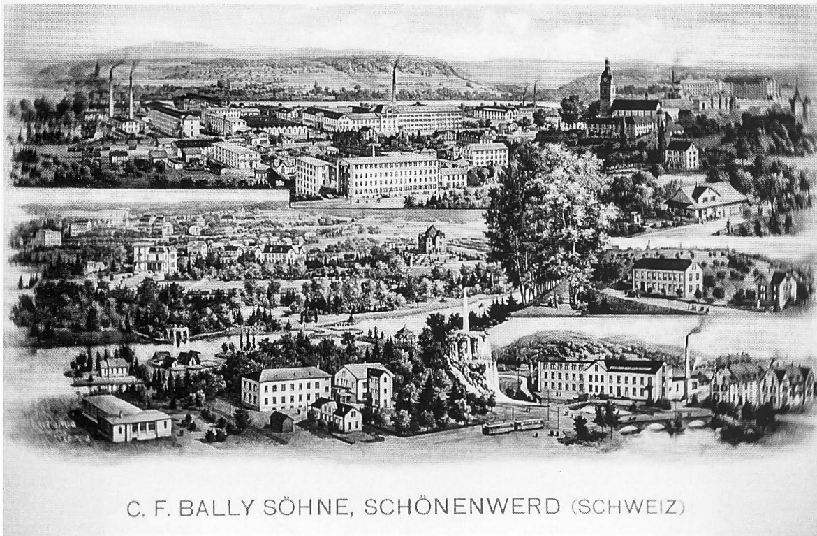
Abb. 7. Auf einem Werbeplakat von 1905 demonstrierte die Firma Bally Grösse und Wohlstand. Die Vielfalt an verschiedenartigen Gebäuden überrascht: Fabrikationsgebäude mit rauchenden Kaminen, Stammhaus der Ballys, die Villen «Jurablick» und «Felsgarten», die Stiftskirche (C.F. Bally unterstützte die Renovation finanziell), das Chorherrenhaus (von C.F. Bally gekauft und in ein Altersasyl umgewandelt, danach Kleinkinderschule), die Eisenbahn (Zentralbahn Olten–Aarau auf Bestreben Ballys über Schönenwerd führend, ab 1856), ein neues Schulhaus (C.F. Bally finanzierte den Bau mit), Angestellten- und Arbeiterhäuser, eine Plantanenallee (unter C.F. Bally angelegt), ein Wasserfall mit Zementkonstruktion (erbaut unter C.F. Bally), Teile des Bally-Parks wie künstliche Inseln, chinesischer Pavillon, Waldkapelle, Felsgrotten und die Pfahlbauten. (Eduard Bally, Geschichte der C.F. Bally AG, 4 Bde., Typoscript; Foto Archiv Bally Schuhmuseum)
