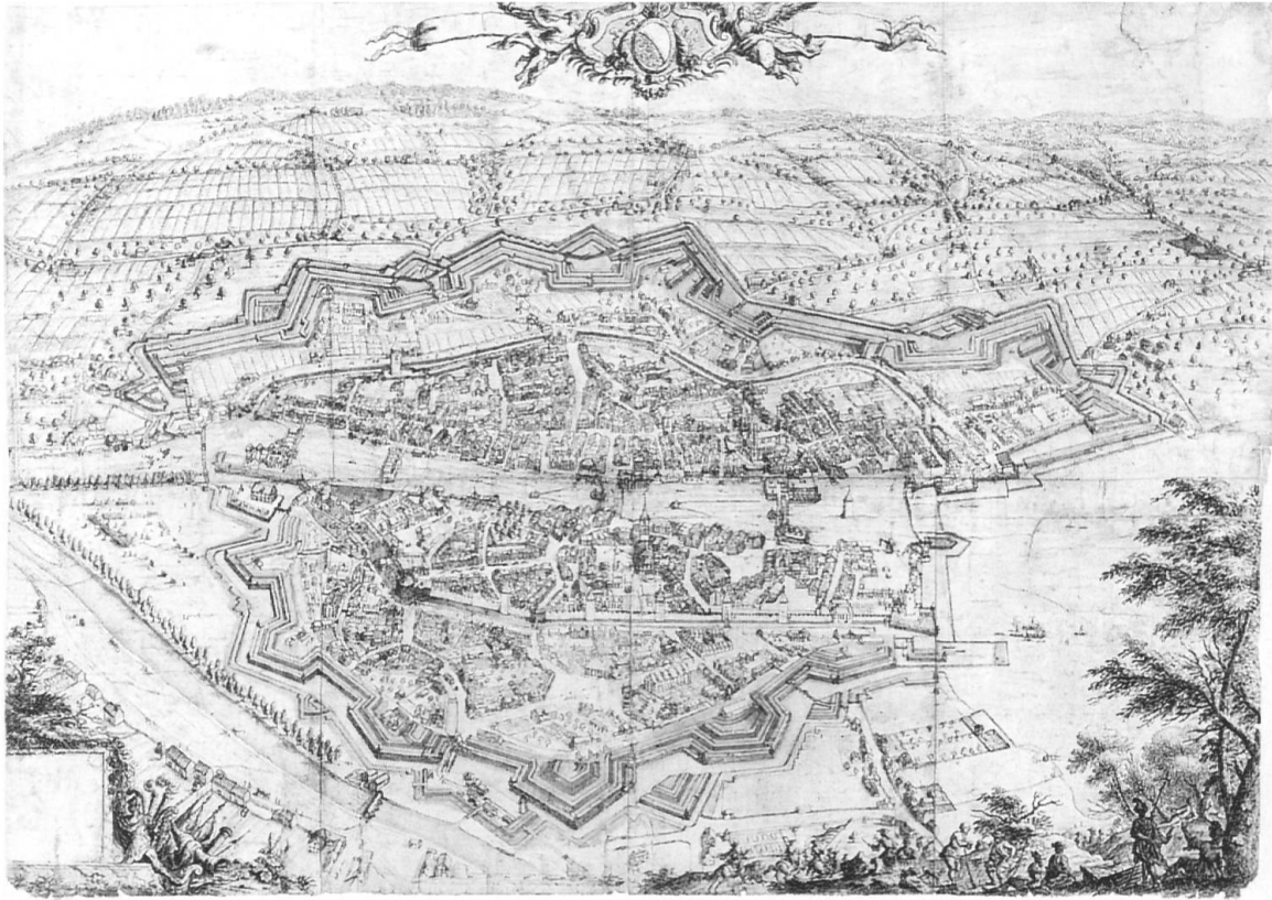
Abb. 36: Planvedute Zürichs von Westen, um 1738, von Johann Caspar Uhlinger. Die realitätsnahe Vedute macht deutlich, wie im schanzenumfassten Zürich der Talacker städtebaulich organisiert wurde (Vordergrund), der mittelalterliche Bering das alte städtische Gebiet nach wie vor einfasst (Bildzentrum) und der Zürichberghang seine lockere, ländlich geprägte Bebauung weitgehend beibehält. Mit der enggefügten Altstadt kontrastieren die weiten Strassenräume besonders des Talackers (Kunstdenkmälerinventarisierung des Kantons Zürich).
