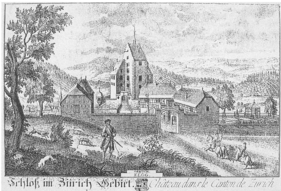
Abb. 14: Elgg – ein repräsentatives Schloss mit grossem Gutsbetrieb. Der die Anlage dominierende mittelalterliche Turm wurde später bis auf die Höhe der Wohngebäude abgetragen (nach Herrliberger, 1741; Kdm).
