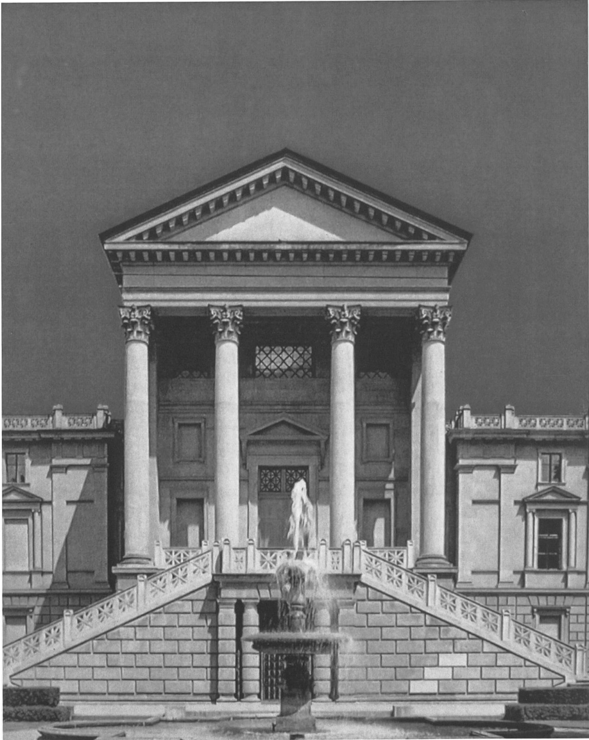
Abb. 15: Das Stadthaus Winterthur (geplant von Gottfried Semper), in dem sich das Stadtarchiv befindet.
