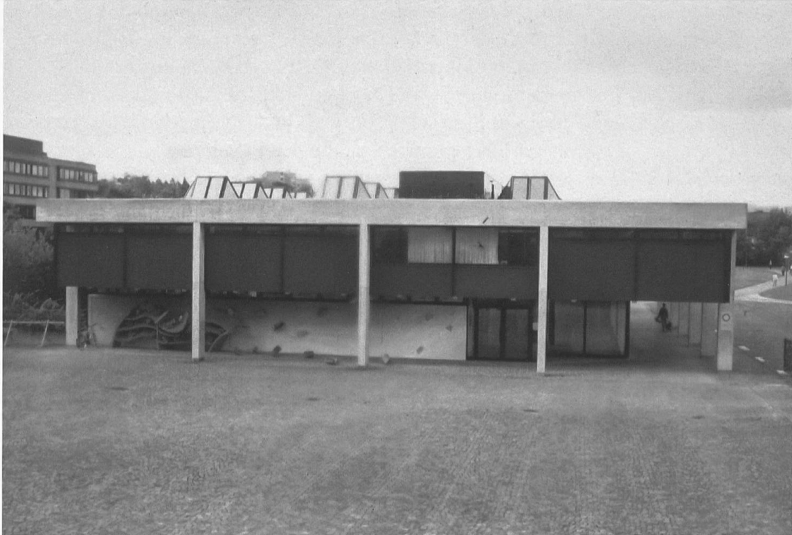
Abb. 10: Das Staatsarchiv Zürich im Irchelpark (Neubau von 1982).
