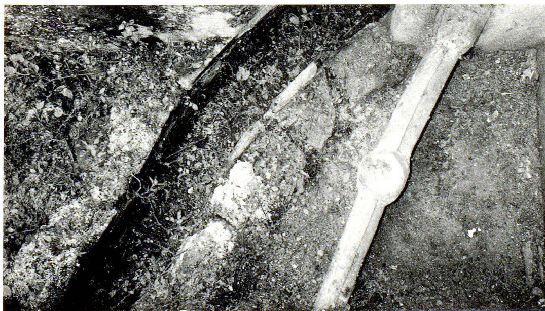
Riva San Vitale TI. Baptisterium. Taufwasser-Zuführ- und Entsorgungsanlagen. Oben und unten rechts: Frischwasserleitung aus Bleiröhren mit Bleimuffen. Unten links: Entsorgungs- kanal aus Tonplatten, römischen Ziegel-Fragmenten und Mörtelboden (in Schacht sichtbar erhalten). Zeichnungen: Verbindungsstelle (Stoss) zweier Bleiröhren. Draufsicht und Schnitt. Fotos u. Zeichnungen Ufficio cantonale dei monumenti storici, Bellinzona (D. Calderara). M.1:4.
