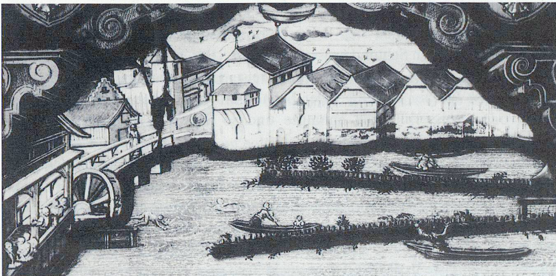
Abb. 21. Das zum oberrn Hüttli gehörende Fach. Der Fischer rammt Pfähle in die Flusssohle und flocht Astwerk in die Zwischenräume.
