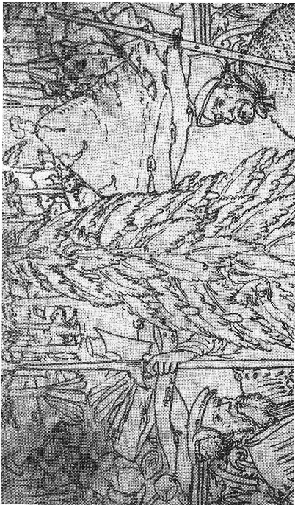
Abb. 8: Köhler bei der Herstellung von Holzkohle: Im Bild rechts ein Kohlenmeiler, links ein Holzspalter, der mit Axt und Bisse die Spalten aufbereitet. Zum Trocknen werden diese Holzspalten rund um einen Baum herum angestellt. — Ausschnitt aus einem Scheibenriss von Hieronymus Lang, 1556, Antiquarische Gesellschaft in Zürich, AG 12001 (Photo: SLM).
