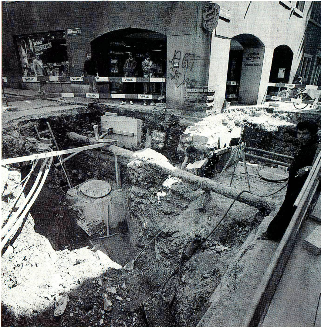
6+7 Vor dem Zunfthaus «Zur Schmieden» (Ecke Marktgasse/Rindermarkt) hat sich über 1,3 Meter unter der aktuellen Pflasterung ein Rest der dreifachen Strassenkoffierung erhalten: Jede der kiesigsandigen, stark verdichteten Packungen (I-III) ist gut 10 Zentimeter stark.
