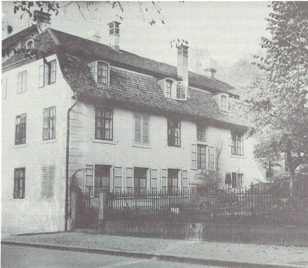
Der «Neuberg» am Hirschengraben, wo Alfred Escher seine frühe Jugendzeit verbrachte. Photographie des Tiefbauamtes Zürich vom 7. November 1929. (Baugeschichtliches Archiv der Stadt Zürich).
