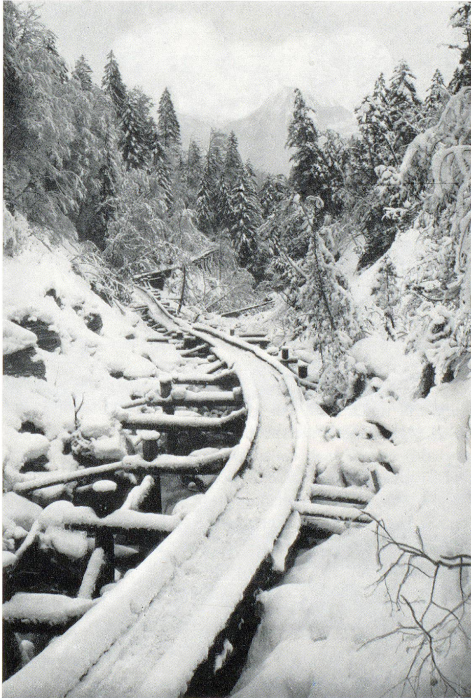
Abb. 17. Die kunstvoll gebaute Holzriesen am Hang und im Einschnitt im Schlierental OW.
