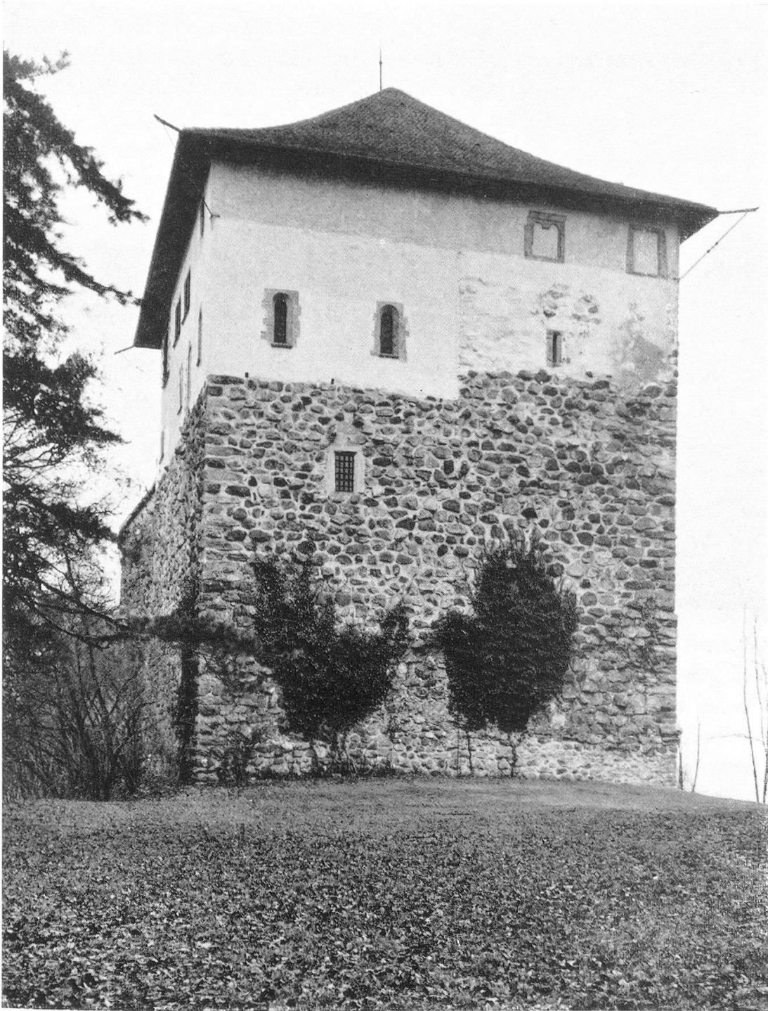
Mörzburg bei Winterthur Stammsitz der Herren von Winterthur; um 1120 von Adalbert von Mörzburg durch Um- mantelung der älteren Anlage verstärkt
