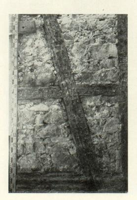
32. Riegelwerk mit Bruchsteinfüllung einer Außenmauer von 1660
