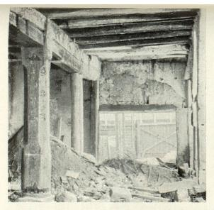
29. Erdgeschoß von Norden 1936/37; Balkendecke, Unterzug, profilierter Stützbalken
