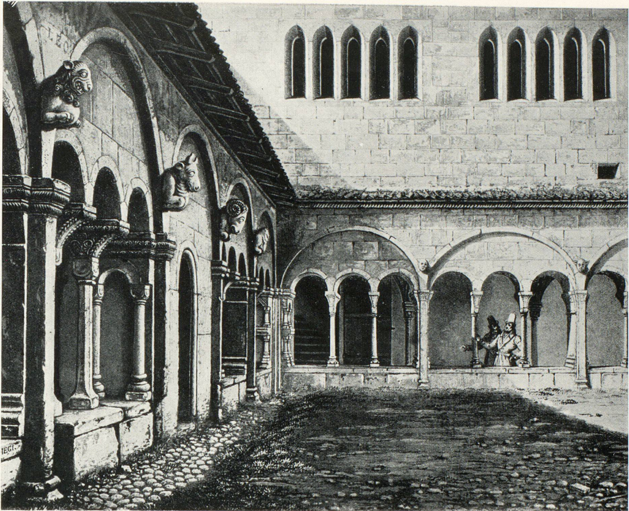
Abb. 1. Ursprünglicher Kreuzgang. Hof nach Südosten. Aquatintablatt von F. Hegi
