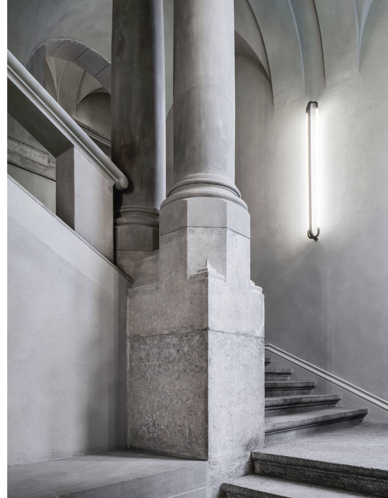
L'aile de l'ancienne école d'arts appliqués a été rénovée avec amour jusque dans les moindres détails, de manière à se marier parfaitement avec le nouveau bâtiment du musée.
