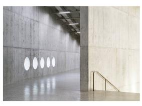
Les fenêtres rondes ont été fraisées dans le béton et peuvent être fermées si nécessaire.
