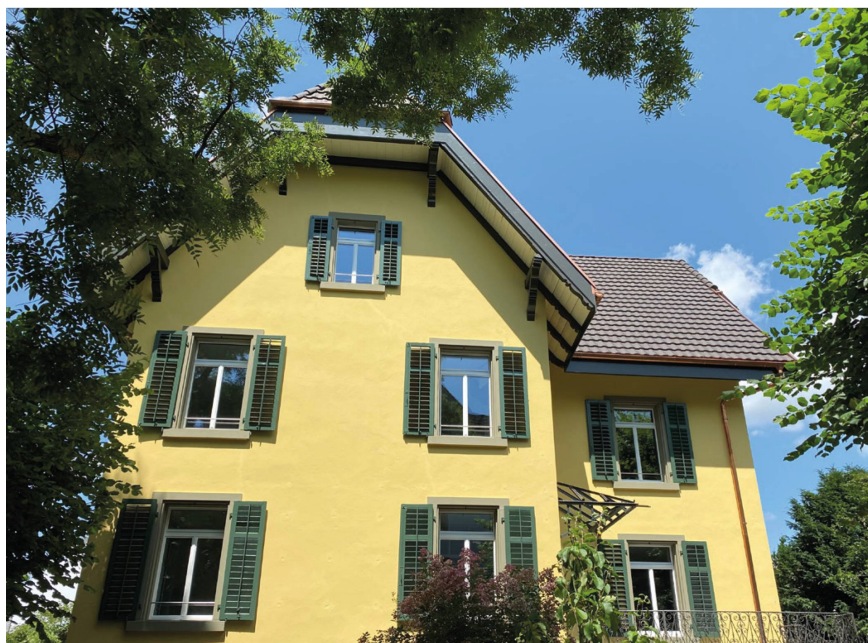
Das renovierte Alte Pfarrhaus der Reformierten Kirchgemeinde zvg
