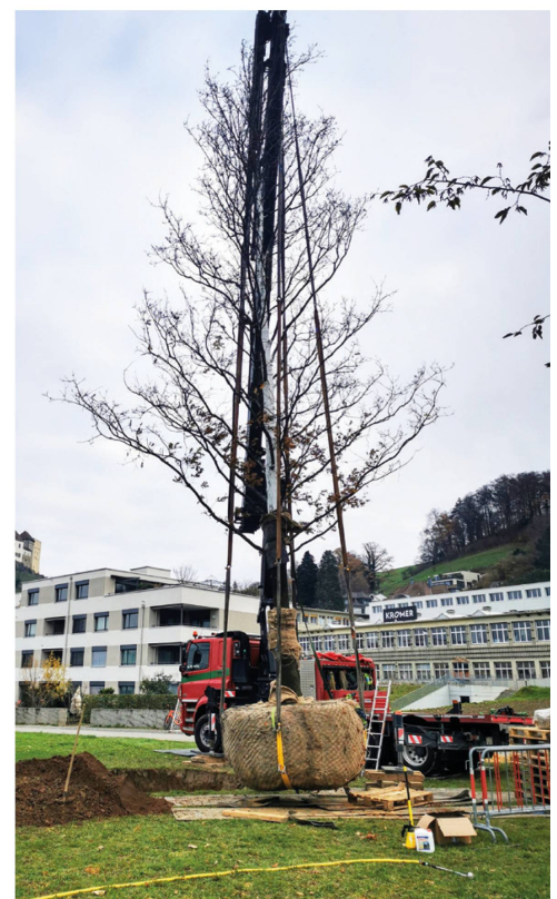
Eine gut zwölf Meter hohe Zerreiche wird im Widmi-Park eingepflanzt FT
