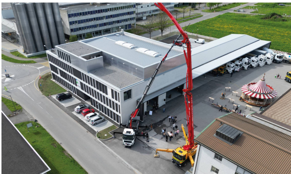
Das neue Betriebsgebäude der Beton Niederlenz-Lenzburg AG und PAG Pumpbeton AG zvg
