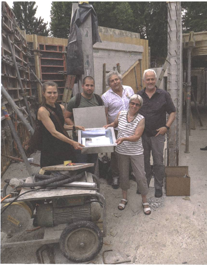
Grundsteinlegung für die neuen Alterswohnungen in der Oberen Mühle FT
