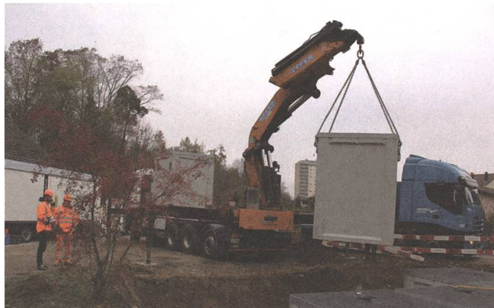
Montage einer Unterflur-Sammelstelle AG
